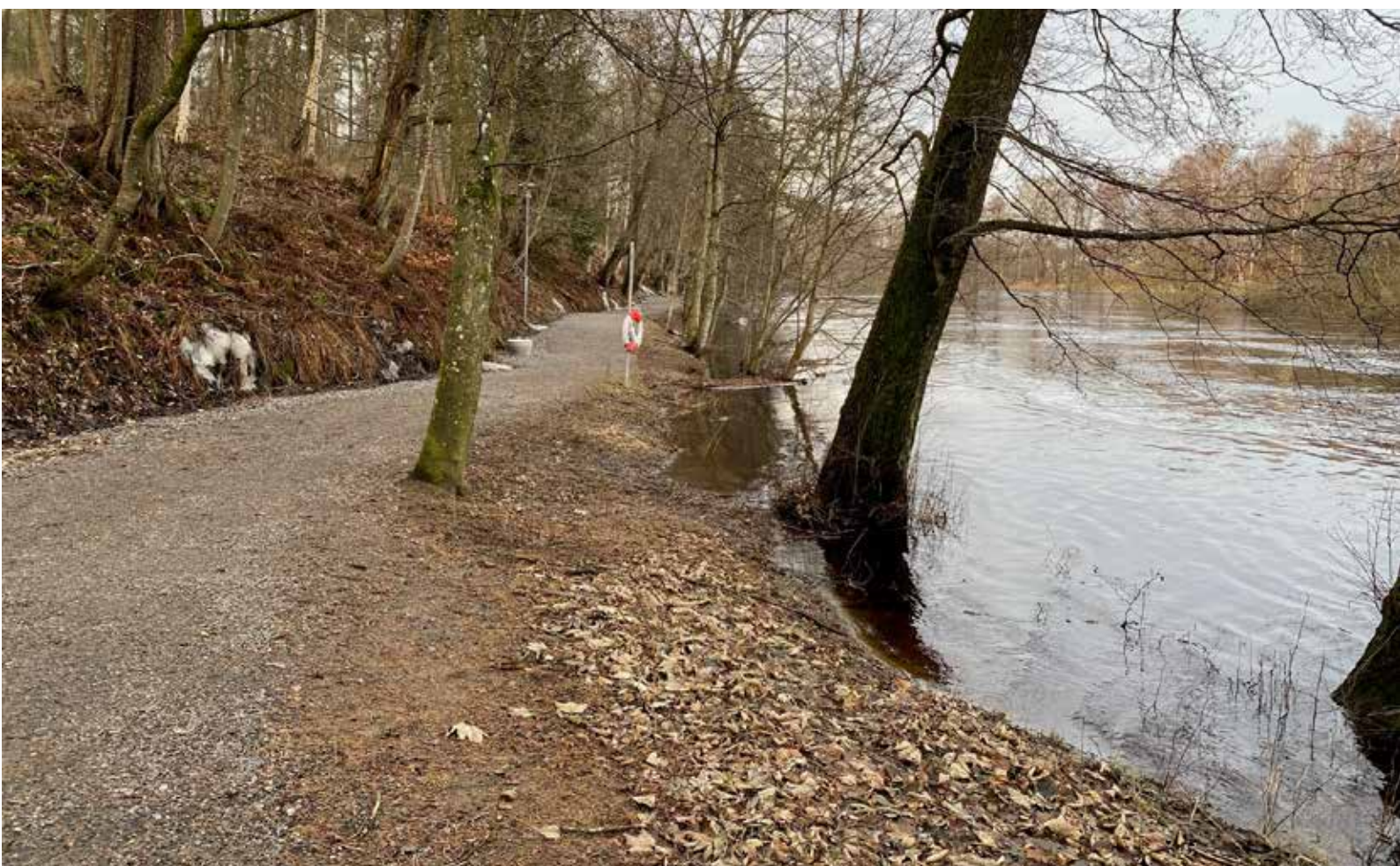
Åtran som rinner genom Falkenberg svämmas flera gånger per år och orsakar avstängningar och översvämning på både vägar och byggnader
